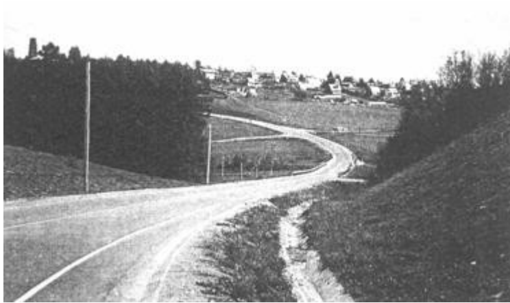
Рис. 3. Организация поверхностного водоотвода на одной из автомобильных дорог в Дмитровском районе Московской обл. (2000 г.)
